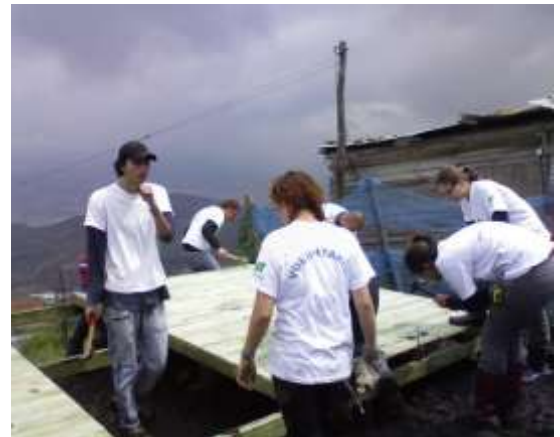
Assembling the floor panels, El Recuerdo, Ciudad Bolivar
